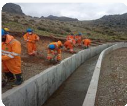
CONSTRUCCIÓN DEL CANAL DE CORONACIÓN, FABRICACIÓN E INSTALACIÓN DE GUARDAS RELAVERA CHUMBE – YAURICOCHA
