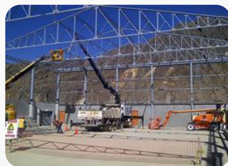
CONSTRUCCIÓN DE MUROS DE CONTENCIÓN Y ESTRUCTURAS METÁLICAS
