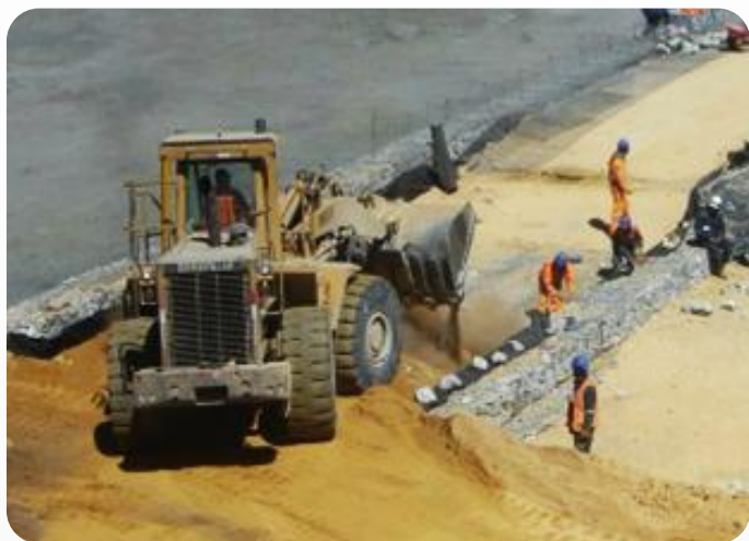
CONSTRUCCIÓN DE DIQUES EN RELAVERA Y POZAS DE SEDIMENTACIÓN
