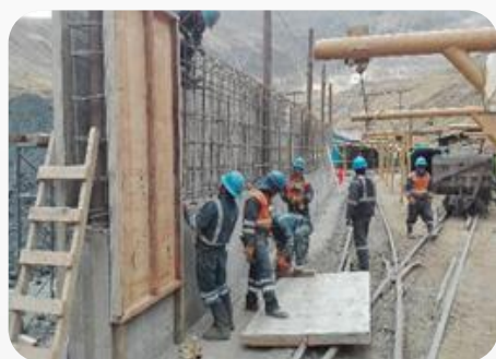
CONSTRUCCIÓN DE MUROS DE CONTENCIÓN Y ESTRUCTURAS METÁLICAS
